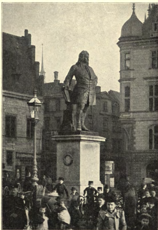
Denkmal in Halle.
